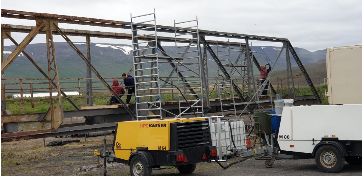
Gamla Blöndubrúin sandblásin og máluð. Hún verður göngbrú í Hrútey frá árinu 2021.
